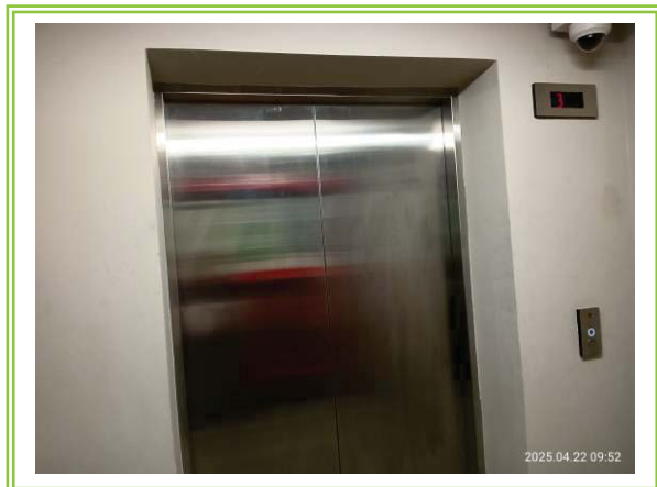
รูปที่ 3-46 ลิฟต์ดับเพลิง
