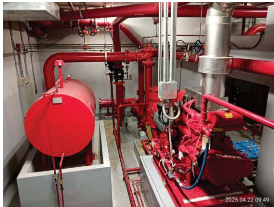
รูปที่ 3-40 เครื่องสูบน้ำดับเพลิง (Fire Pump)
