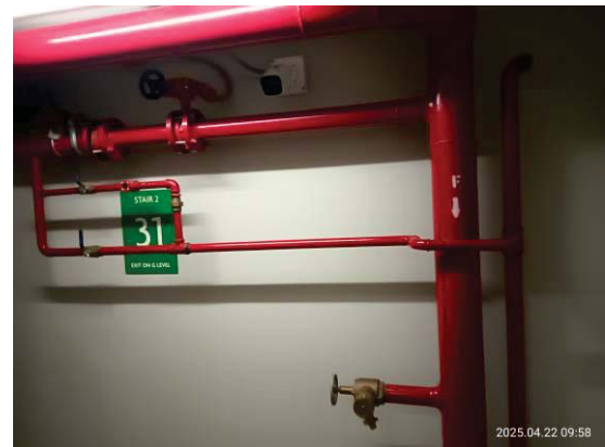
รูปที่ 3-41 ระบบท่อยืน (Stand Pipe)
