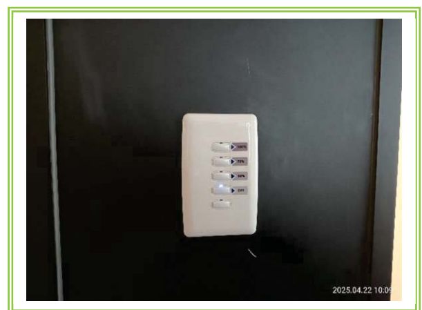
รูปที่ 3-38 เครื่องปรับระดับแสงสว่าง พร้อมจอแสดงผล จุดติดตั้งแสงสว่าง
